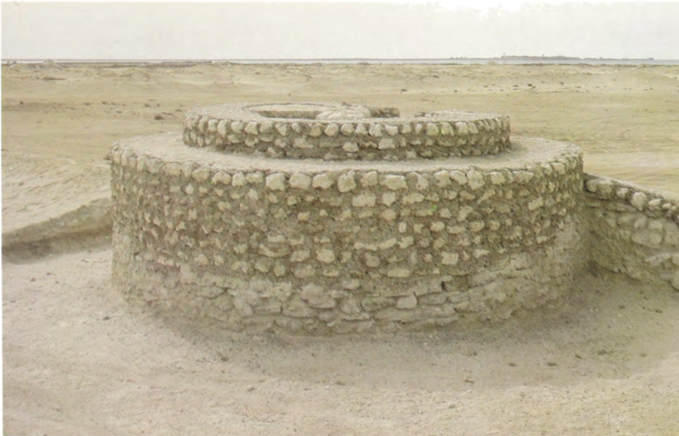
الزبارة - نفس البرج بعد الترميم
